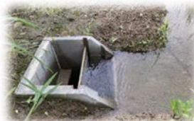
田んぼダム専用排水樹の購入・設置
