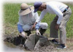
せき板設置後の管理作業
