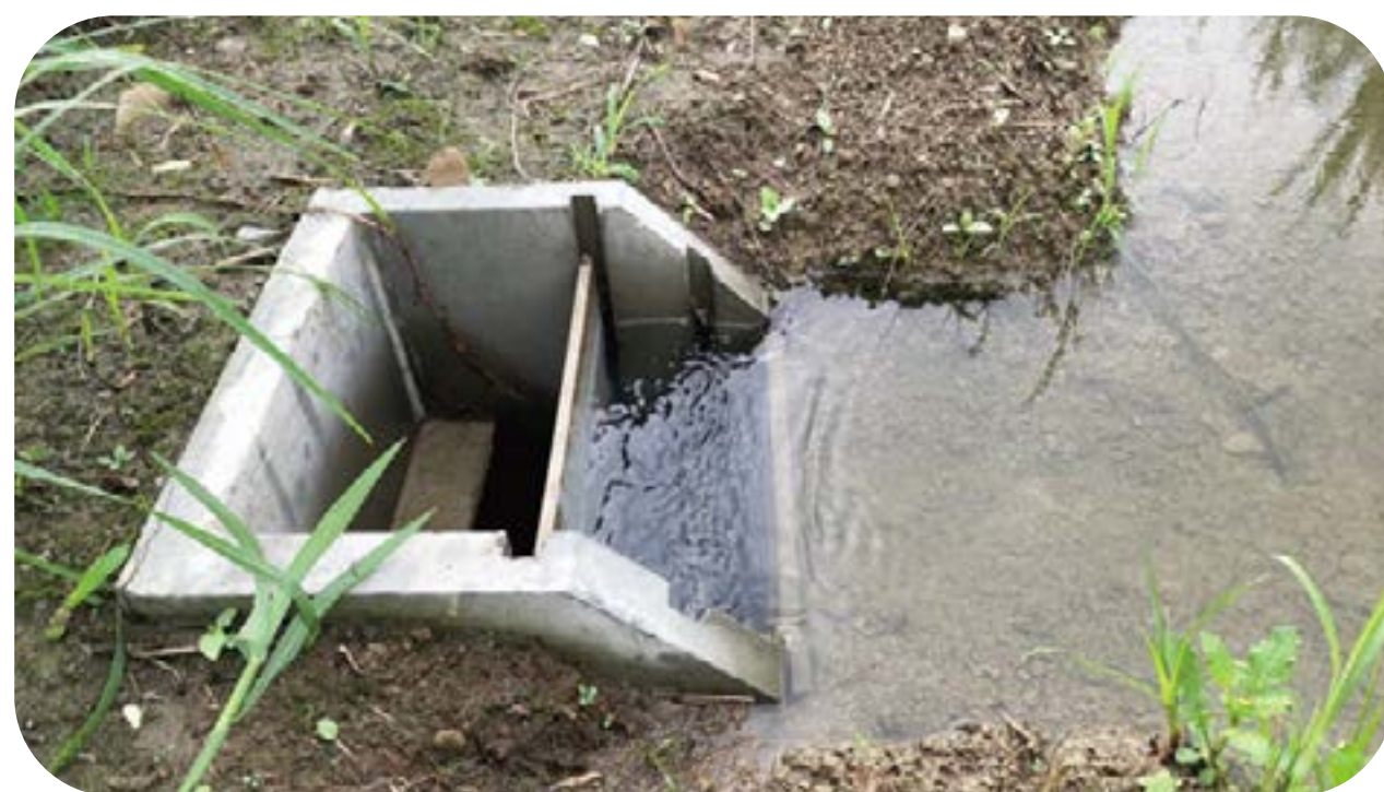
老朽化した排水樹を田んぼダム専用 排水樹へ入替え(貯留効果発揮中)
