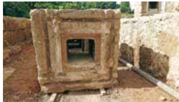
吹上樋を構成する通水石管 ※山都町提供
