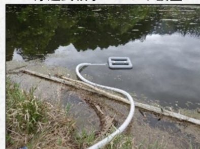
浮遊式吸水ユニット設置
