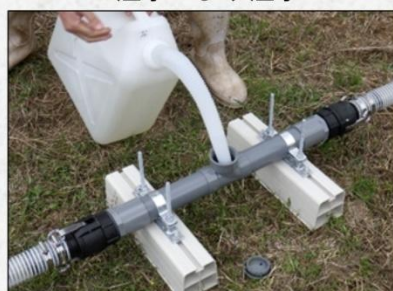
注水口より注水
