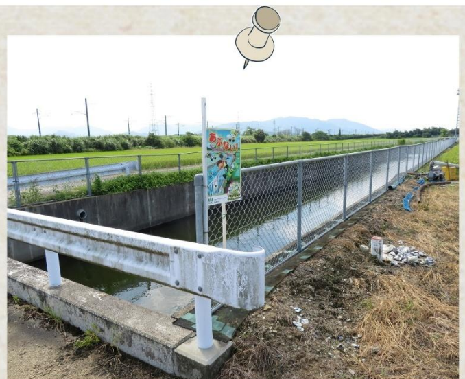
②北新田導水路
