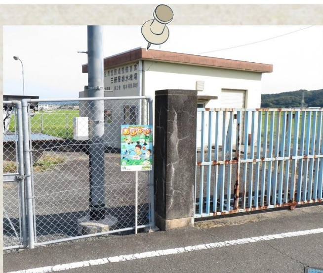
①三軒屋排水機場
