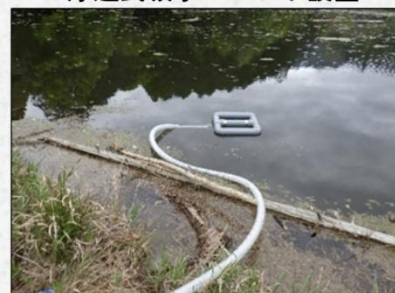
浮遊式吸水ユニット設置
