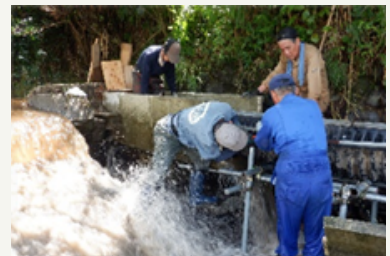
▲用水路の仮復旧
