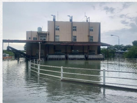
▲氷川排水機場
