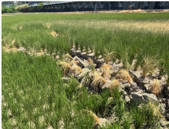
▲農地の亀裂 (氷川町)
