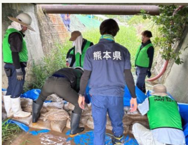
▲水路への応急ポンプ設置
