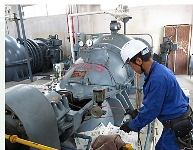
▶施設の適切な点検が不具合の早期発見に繋がり、施設の機能保持及び事故発生リスクを低減。
